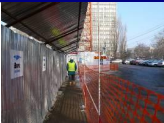
Protection du public contre les risques d'opérations de levage
