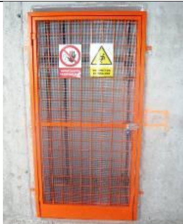
Cadre métallique fixe et passage fermé
