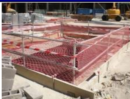
Protection des bords avec filet horizontal et grille verticale
