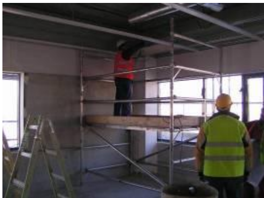
Utilisation d'une Tour préférée à l'échelle
