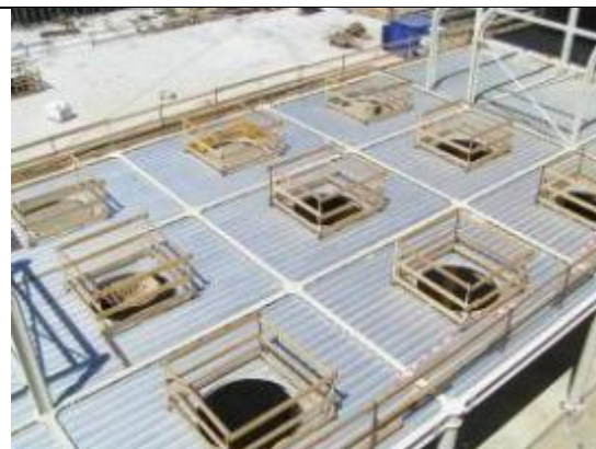
Protection d'ouverture du toit
