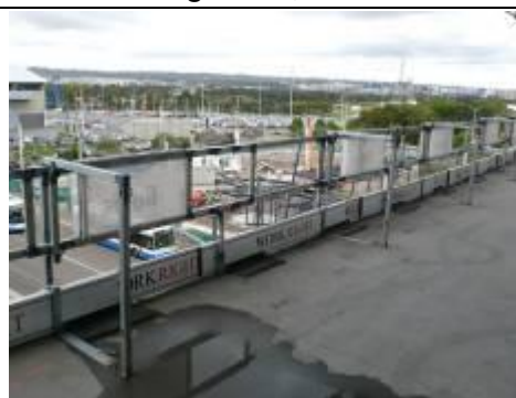
Système de protection emboîté avec stabilisateurs
