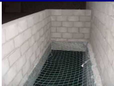
Mur et filet de blocage
