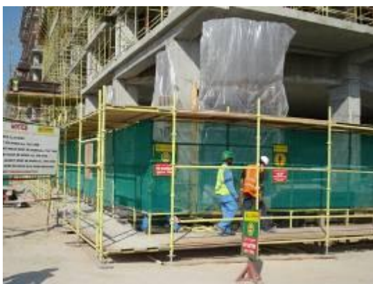
Protection des travailleurs contre les risques d'opérations de levage
