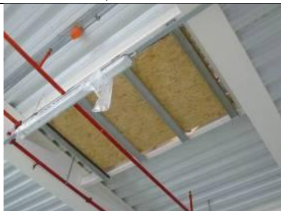
Protection d'une ouverture – vue d'en bas
