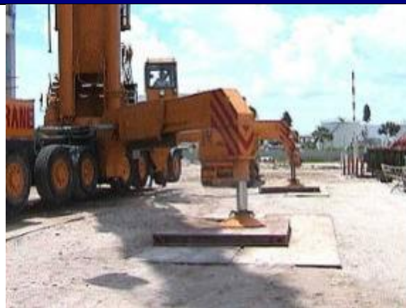
Grue mobile avec plaque de stabilisation en place
