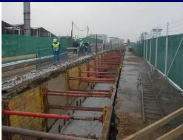
Étalement vertical et support de protection de la voie
