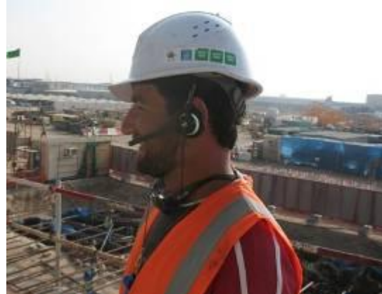
Communication radio à main libre entre le chef de manœuvre et l'opérateur grue
