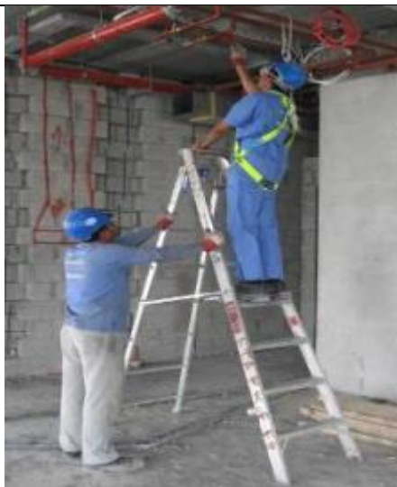
Soutien de l'échelle par un collègue ( échelles ne doivent être utilisées qu'en dernier )
