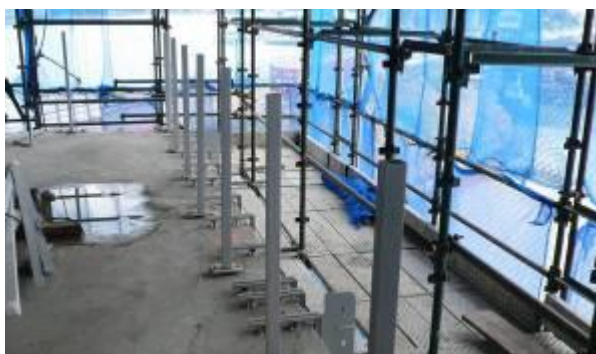
Vue intérieure: d'un échafaudage de façade
