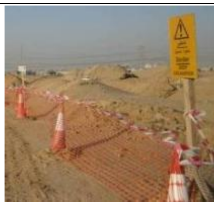
Panneau d'avertissement, barrière de monticule terre avec filet de signalisation
