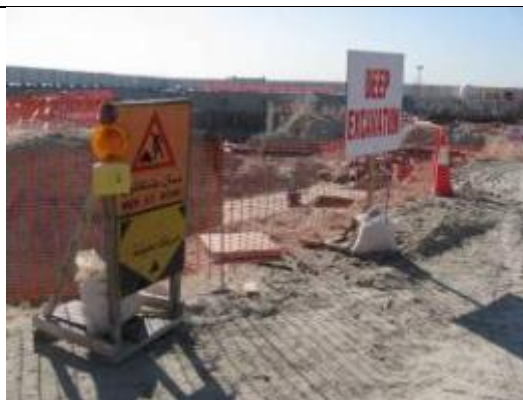
Signalization d'alerte et gyrophare
