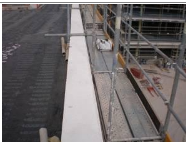
Plateforme/échafaudage métallique avec plancher correctement fixé
