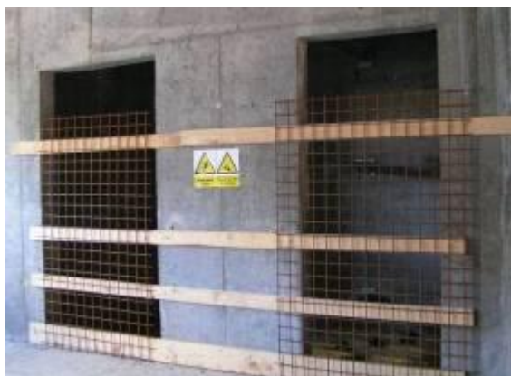
Grillage et bois pour protection cage d'ascenseur
