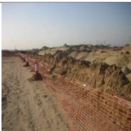
Utilisation des monticules de terre comme protection de bord pour de longues durées de tranchées
