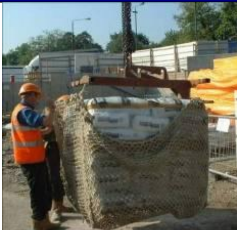
Filets utilisés comme précaution pour les charges instables
