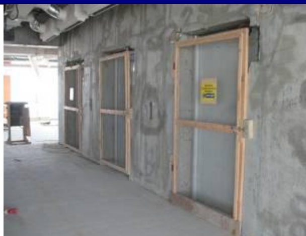
Bois et grille pour fermeture passage
